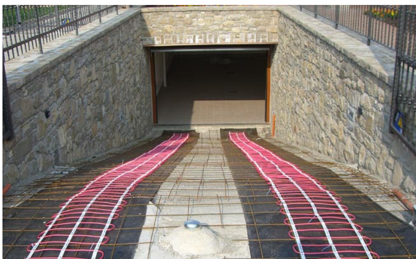
Snowmat installato su un telo isolante
